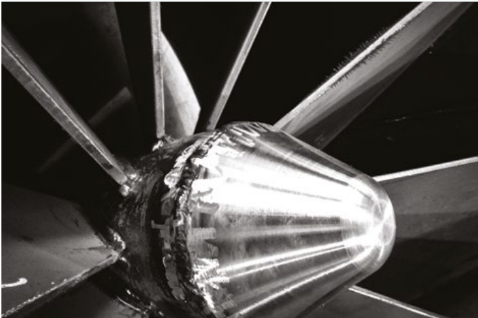
↑ Separátor popílku ve spalínovodu
