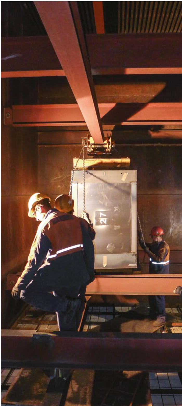
↑ Instalace modulů do SCR reaktoru
