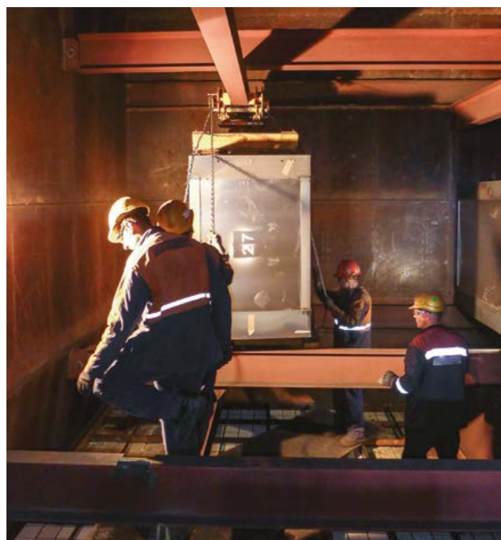
↑ Установка модулей в реактор селективного каталитического восстановления
