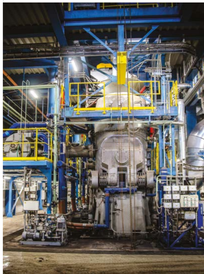
↑ Вертикальные валковые мельницы с опрокидными бегунами. Установка энергетического источника на производстве
