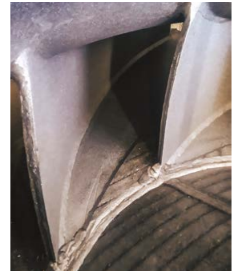
↑ Применение износостойких материалов в вентиляторе
