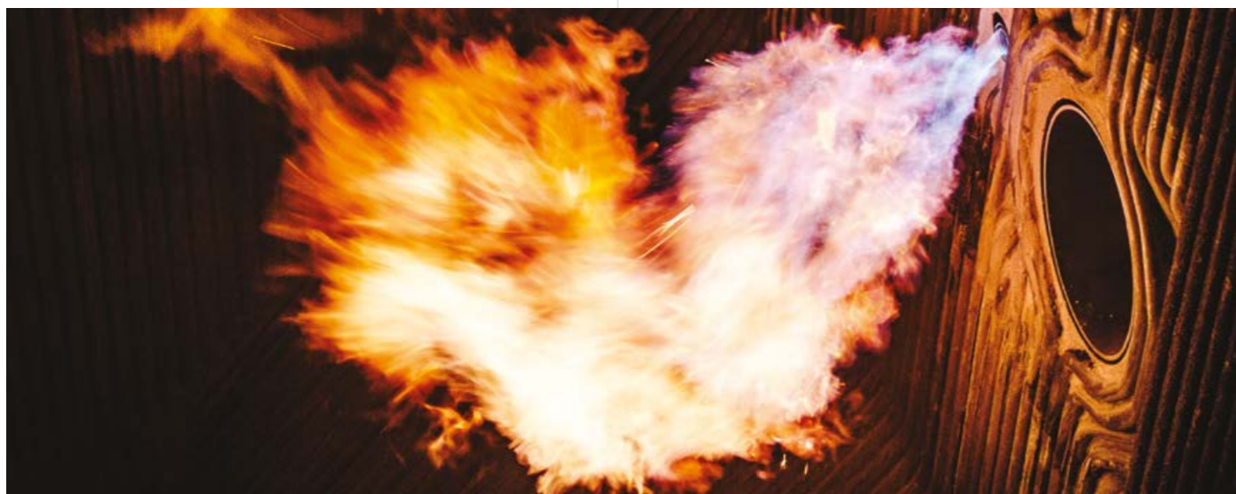
↑ Запальная и стабилизационная газовая горелка
