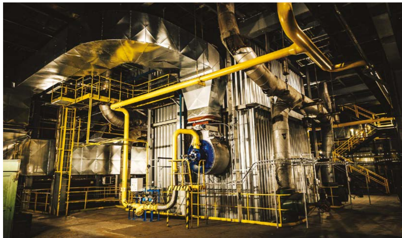
↑ Газовый водогрейный котел 116 МВт
