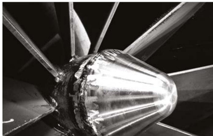
↑ Сепаратор летучей золы дымовом канале
